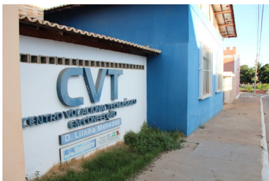
Foto 22: Vistoria Técnica – CVT Salgueiro– Março/2014
