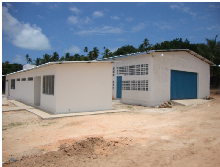
Foto 03: Construção do galpão de Tamandaré - (PRO-RS, 2014)
