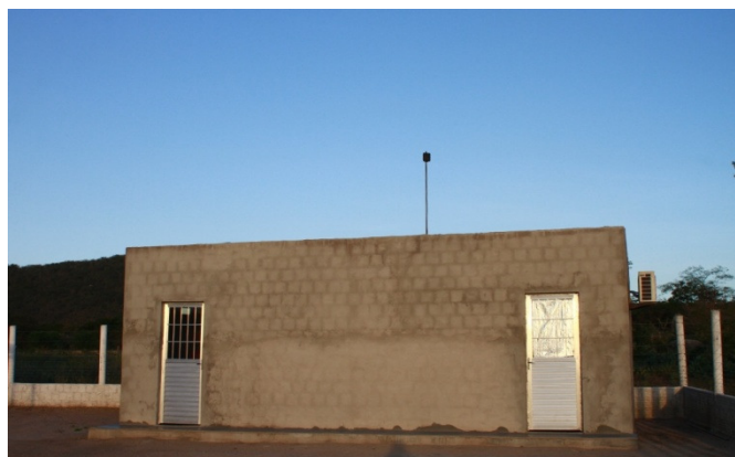
Figura 07 - Detalhe da sede administrativa do Laticínio Luiza com antena 3G, Venturosa-PE (10/05/2016) Foto: Heitor Salvador
