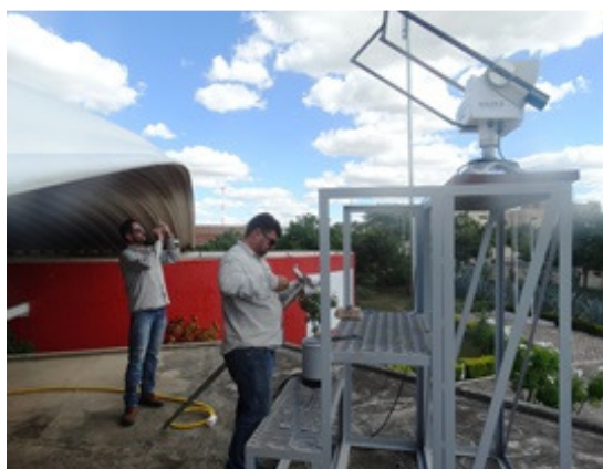
Foto - Instalação da Estação Solarimétrica
