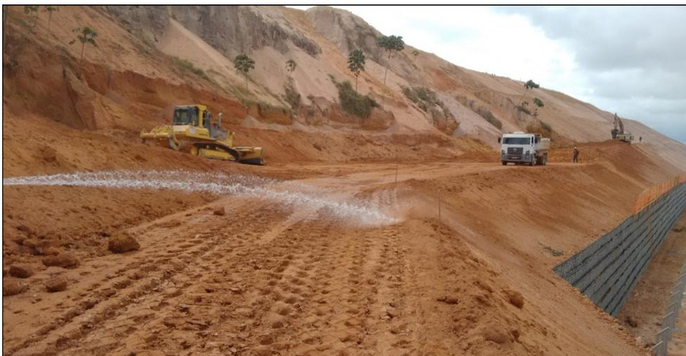
*Aterro compactado em talude do reservatório do Jordão*
