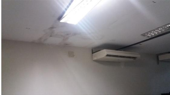
Figura 9- Estrutura do CTCD. Teto do laboratório de informática com infiltrações.
