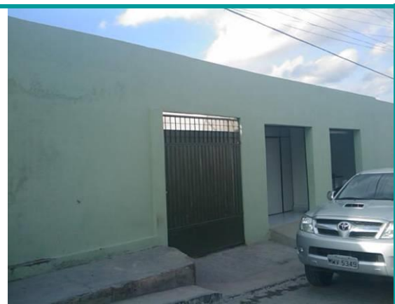
Lavanderia localizada no Município de Toritama
