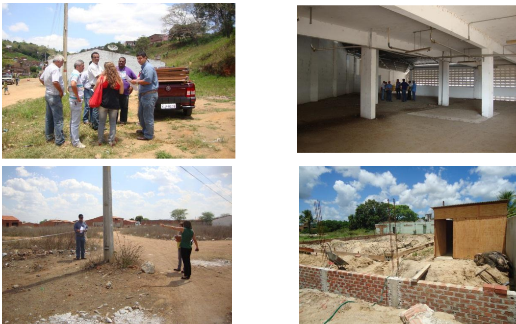
Figura 114. Serviços de acompanhamento das obras dos CVTs.
