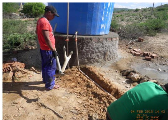
Figura 2.7-8 - Construção de infra-estrutura para
