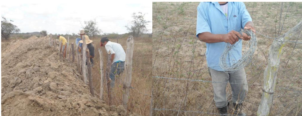
Figura 2.10-38 – Remoção da Cerca Existente (Desgastada)
