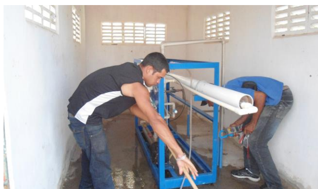
Figura 2.7-12 - Dessalinizador recuperado na localidade de Bebedouro - Passira – PE.
