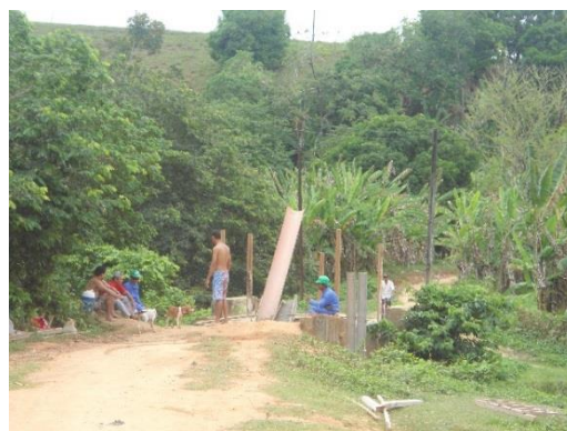
Figura 2.3-9 - Acompanhamento da construção de Ponte de acesso para a comunidade local
