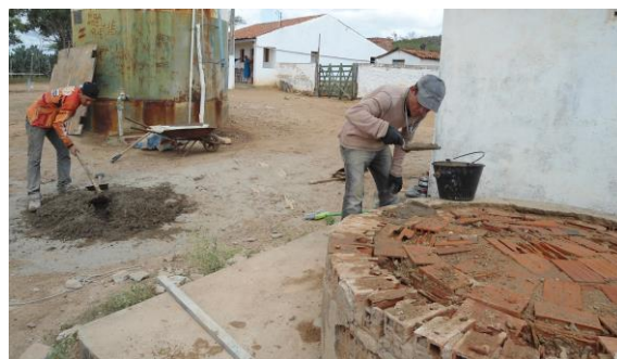
Figura 2.7-24 - Construção de infra-estrutura para as caixas d' água no Povoado Cacimba de Baixo – Santa Cruz do Capibaribe-PE.
