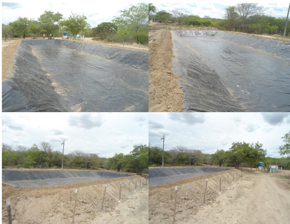
Figura 2.10-3 - Tanque de rejeito pronto
