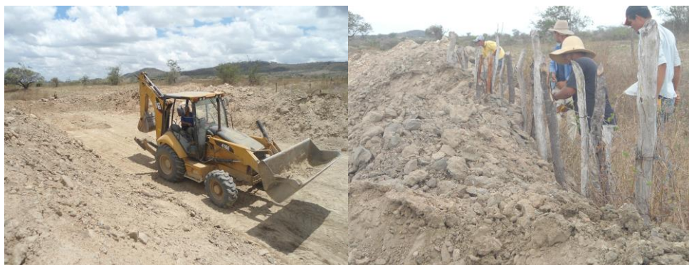
Figura 2.10-7 – Construção de Tanque e da Cerca
