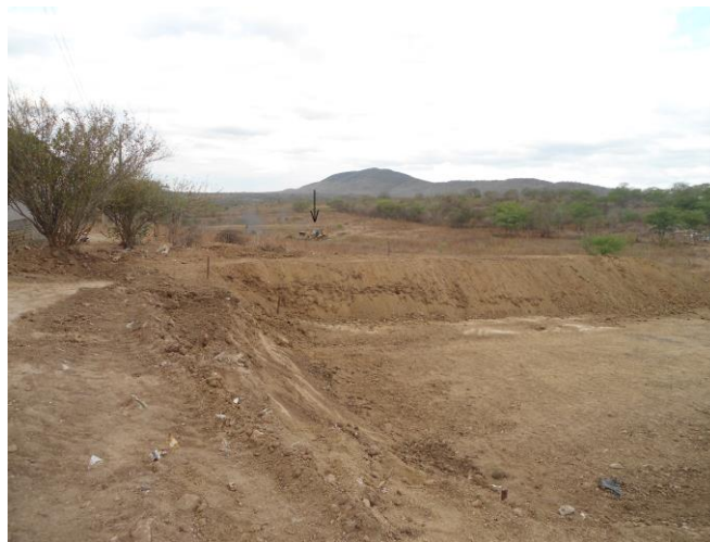
Figura 2.10-34 – Retirada de Material para Construção do Tanque (Beira Mar)
