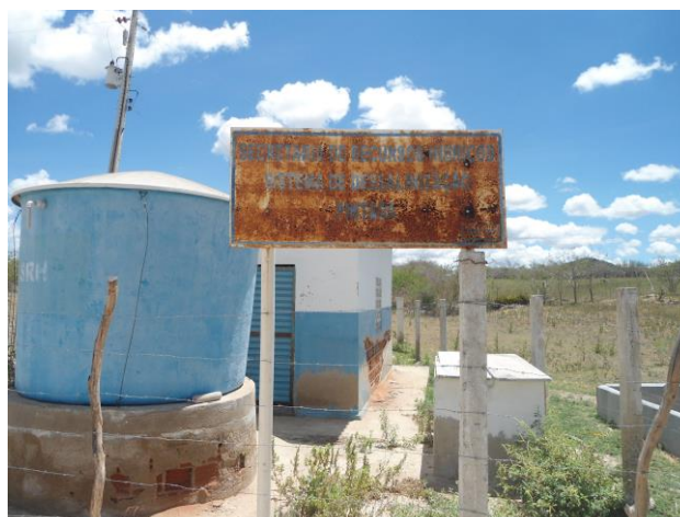
Figura 2.10-17 – Tanque de Rejeito Nivelado e Cercado
