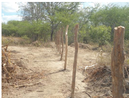
Figura 2.10-37 – Limpeza para Construção da Cerca
