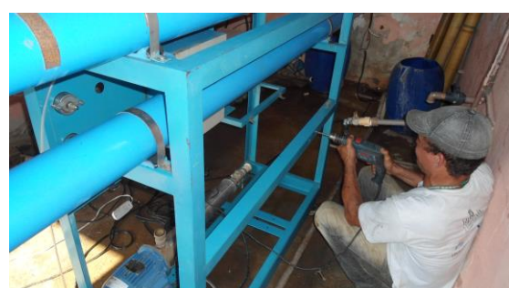
Figura 2.7-26 - Recuperação do sistema de dessalinização na sede do município de Vertentes –PE.
