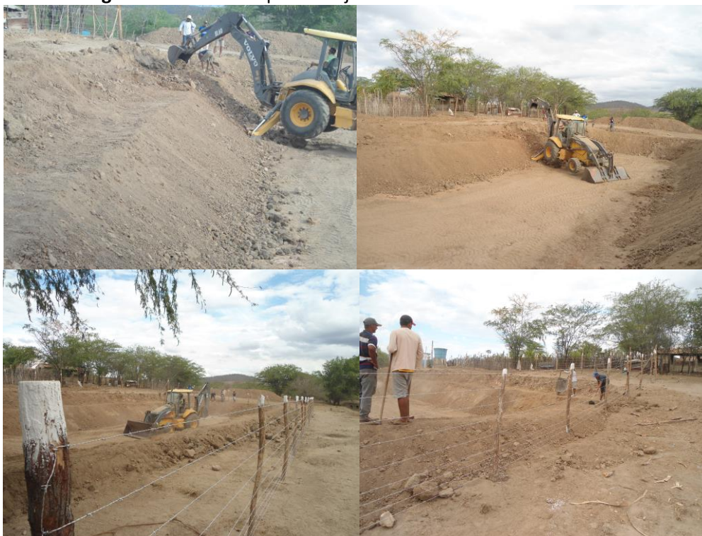
Figura 2.10-14 – Tanque de Rejeito sendo Construído e Cercado
