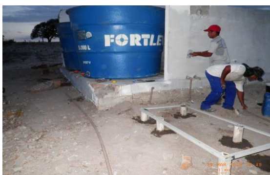
Figura 2.7-11 - Construção de infra-estrutura para as caixas d' água no Sítio Fama Jucati – PE.
