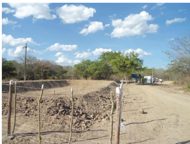
Figura 2.10-2 - Tanque de rejeito nivelado e cercado
