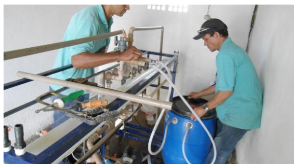
Figura 2.7-28 - Recuperação do sistema de dessalinização no Povoado de Carrapicho – Passira-PE.
