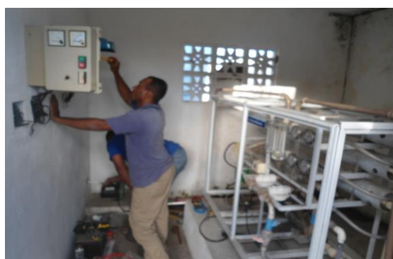
Figura 2.7-21 - Recuperação do sistema de dessalinização na localidade de Aldeia Funi-ô Águas Belas – PE.
