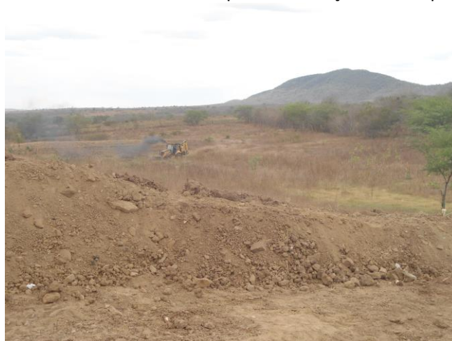
Figura 2.10-33 – Retirada de Material para Construção do Tanque (Beira Mar)
