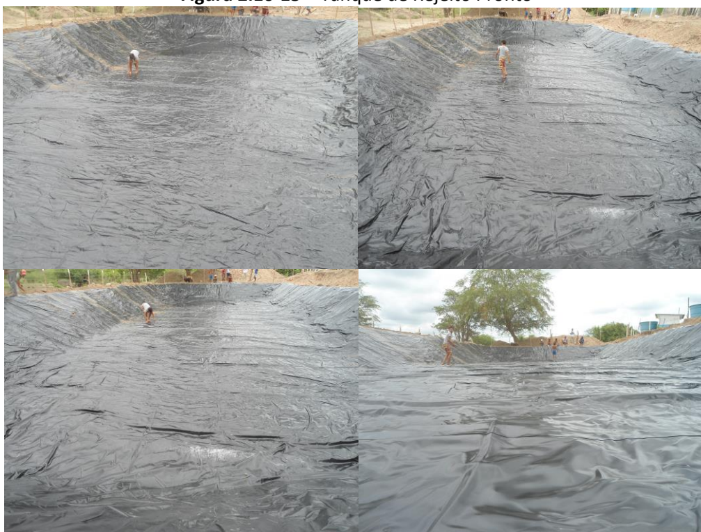
Figura 2.10-15 – Tanque de Rejeito Pronto
