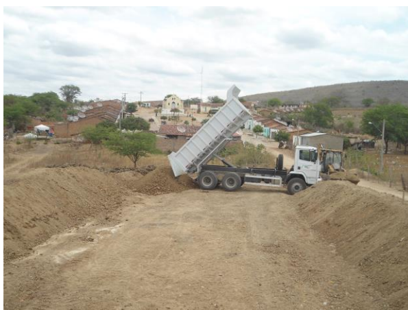
Figura 2.10-5 – Tanque de Rejeito sendo Construído
