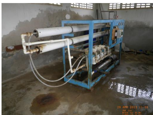
Figura 2.7-13 - Dessorizador diagnóstico para recuperação no povoado de Santo Antonio - Pedra - PE.
