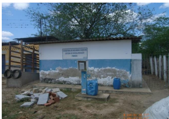
Figura 2.10-21 - Sistema de dessalinização da comunidade de Pinhões – Município de Riacho das Almas
