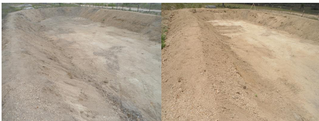
Figura 2.10-17 – Tanque de Rejeito Nivelado e Cercado
