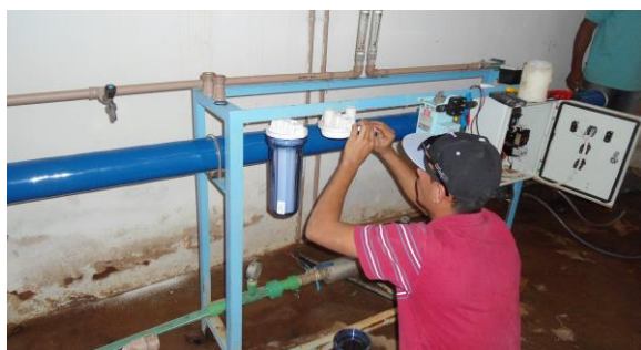
Figura 2.7-25 - Recuperação do sistema de dessalinização no Povoado Rio da Barra – Sertânia-PE.
