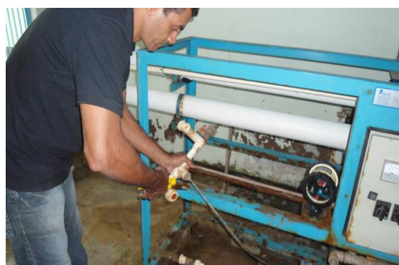
Figura 2.7-22 - Recuperação do sistema de dessalinização no Loteamento Santo Afonso - São Bento do Una – PE.
