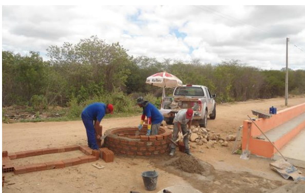
Figura 2.7-14 - Construção de infra-estrutura para as caixas d' água no Sítio Campos Sertânia - PE.
