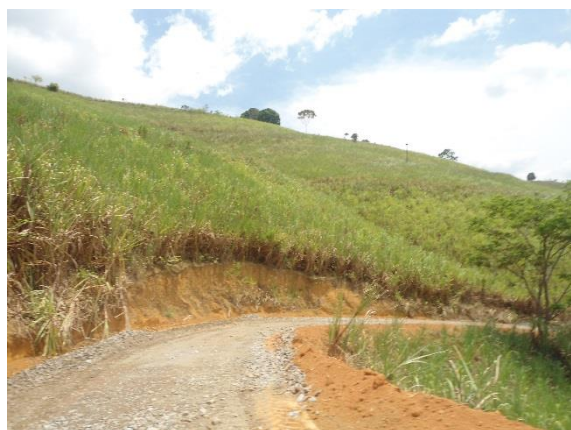
Figura 2.3-10 - Monitoramento e Mapeamento de melhorias de acesso
