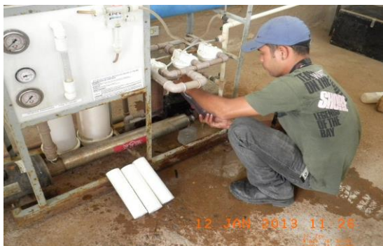
Figura 2.7-3 - Manutenção (troca de filtro) no sistema de dessalinização na localidade de Pilãozinho - Serra Talhada-PE
