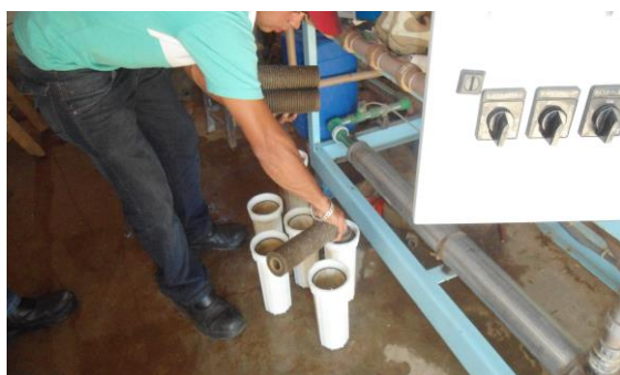
Figura 2.7-19 - Recuperação do sistema de dessalinização na localidade Vila do Pará - Stª. Cruz Capibaribe – PE.
