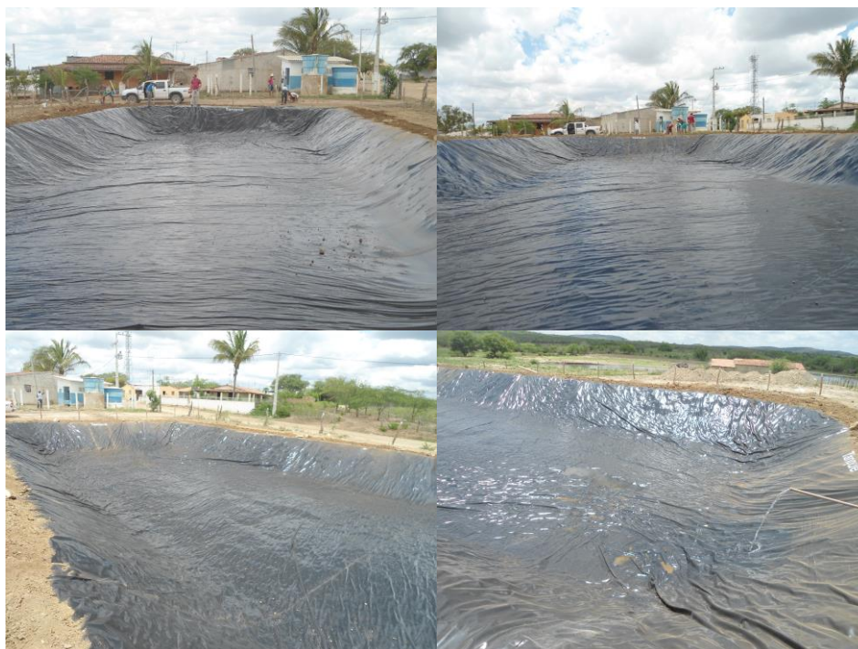
Figura 2.10-12 – Tanque de Rejeito Pronto
