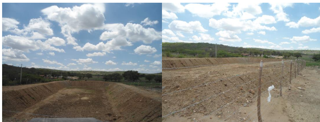
Figura 2.10-11 – Tanque de rejeito Nivelado e Cercado
