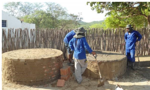
Figura 2.7-4 - Construção de infra-estrutura para as caixas d' água na localidade de Queimada dos Henriques – Igaraci - PE
