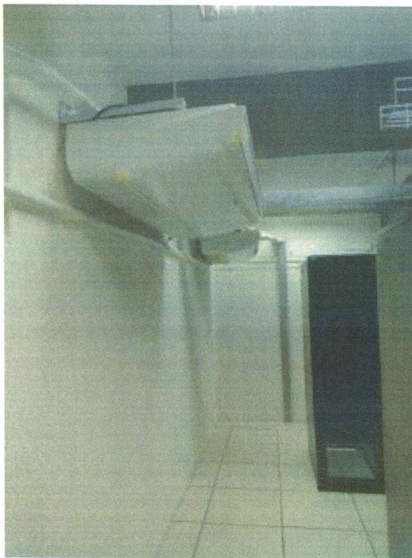
Figura 18 - Novas splits instaladas
