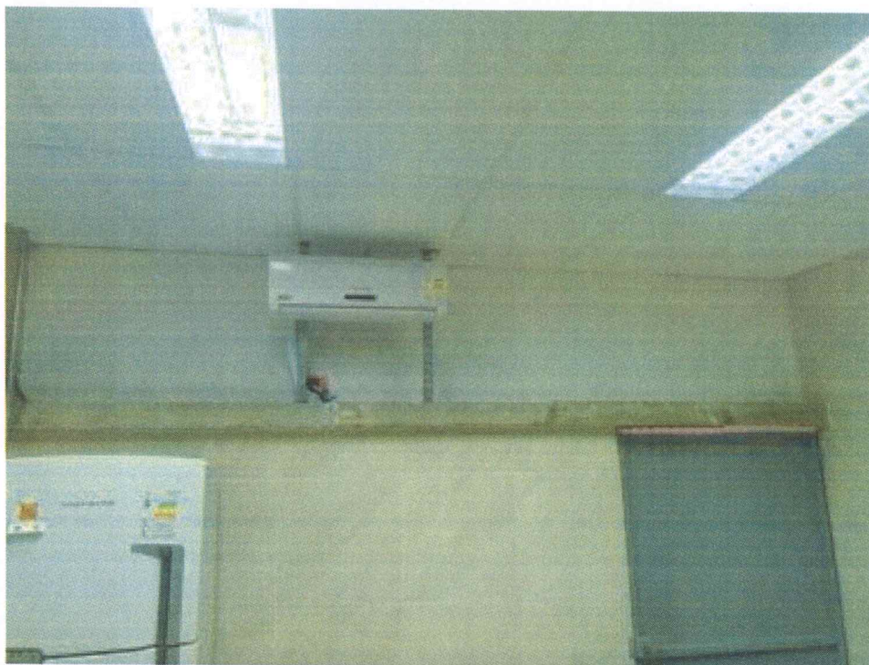
Figura 10 - Portão da copa e fechamento das janelas
