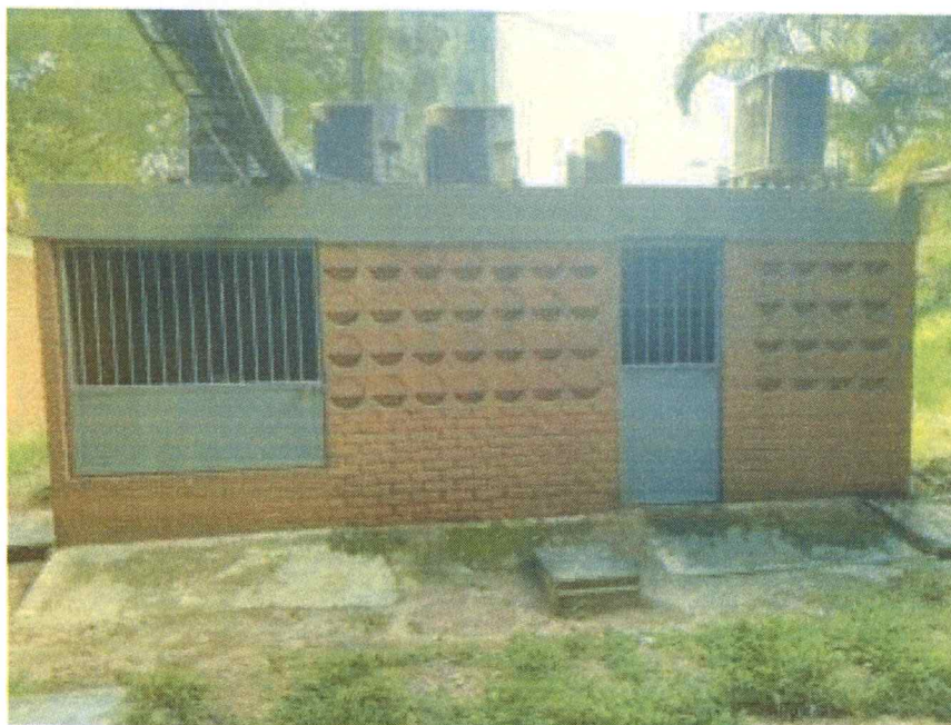
Figura 12 - Reestruturação do abrigo do diesel
